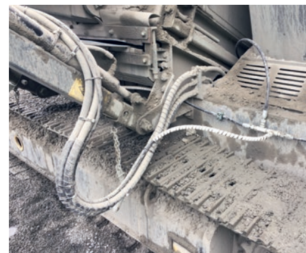
Die Leitungsführung für Wasser und Druckluft erfolgt über Chromstahlverrohrungen und flexible Schläuche.
