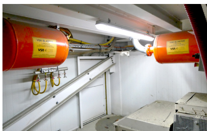
Die 150-Liter-Luftkanonen werden unter dem Silo installiert.
