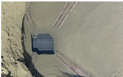
Wichtig: Die genaue Positionierung der Schwertdüsen.
