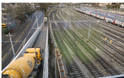
Das Material wird regelmässig abtransportiert.
