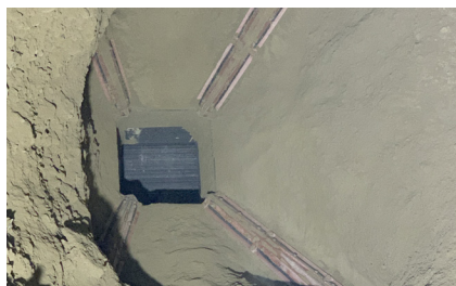
Important: positionnement exact des buses ensiformes.
