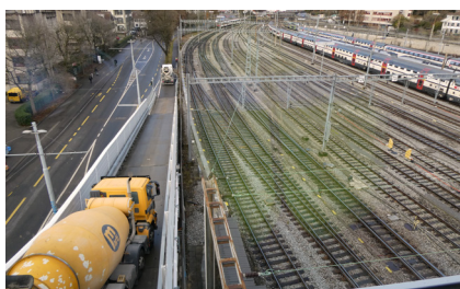
Le matériau est régulièrement évacué.
