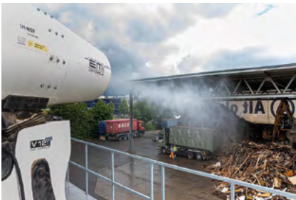
Die Kanone bedüst das Aussengelände.
