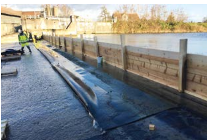
Die Montage dauert fünf Tage.
