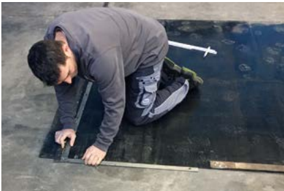
In der Werkstatt wird die Membrane vorgelocht.
