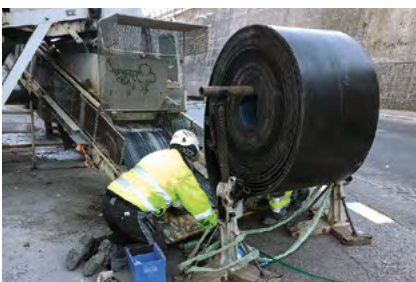
Das neue Förderband wird eingezogen.
