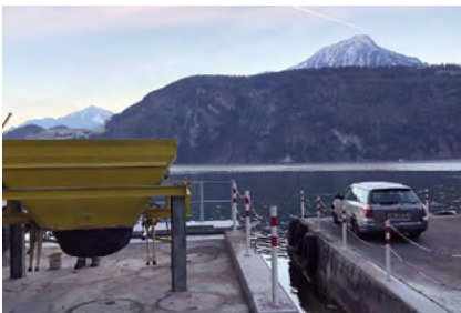
Zum Beschichten wird der Trichter ausgebaut.
