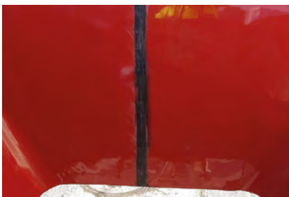
Die PU-Beschichtung ist passgenau eingeklebt.
