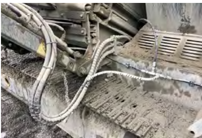
Leitungsführung mit flexiblen Schläuchen.
