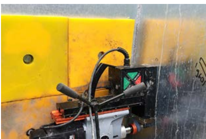
Der neue Übergabetrichter wird beschichtet.
