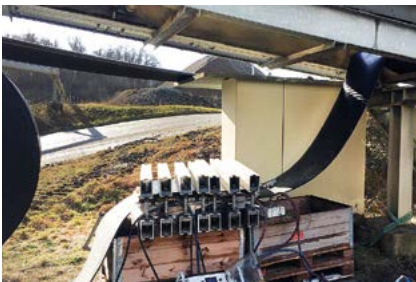
Diverse Förderbänder werden ersetzt.
