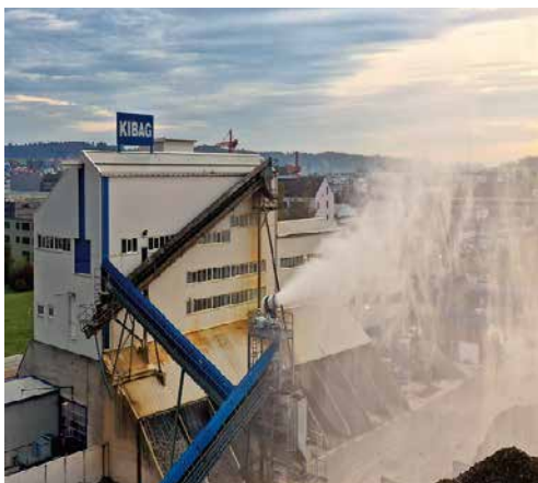
Die V22 im Einsatz bei der Kibag in Regensdorf.
