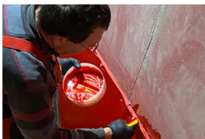
Les bords des panneaux sont jointoyés avec le mastic PUCEST® TIX.
