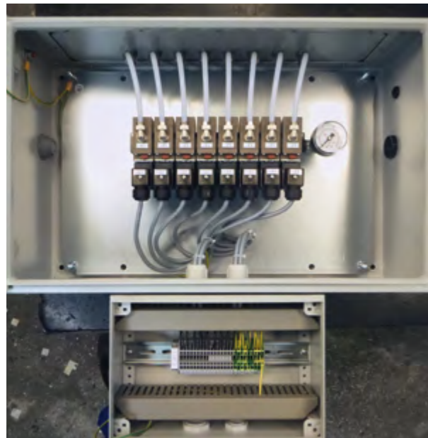
Magnetventilschrank mit Drucküberwachung und Sicherheitsentlüftung
